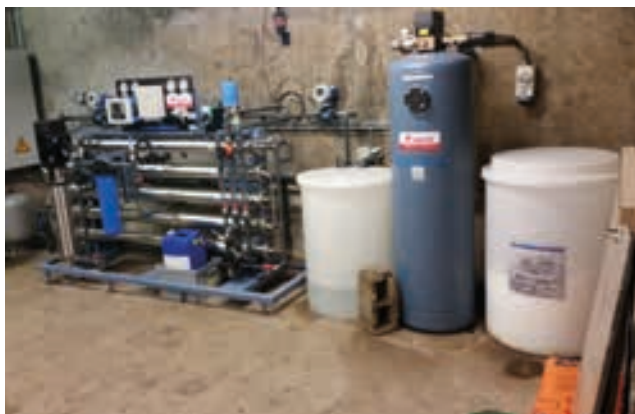
— De omgekeerde osmose installatie voor het demineraliseren van het water. Foto Wim Speliers.
